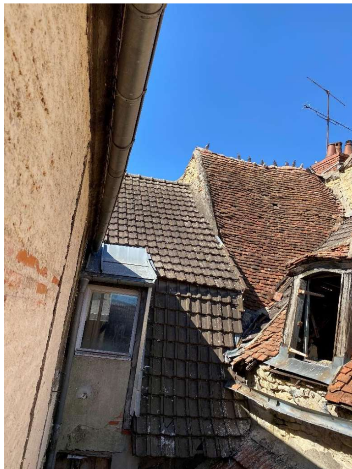
Jonction entre le 5 et le 7 : le 5 tuile mécanique, et le 7 petites tuiles
